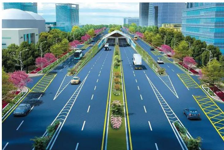
深圳妈湾跨海通道
